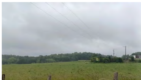
Figure 70: Vue n°3 sur PIP au sud d'Andoumont. Source : Pluris, 2026
